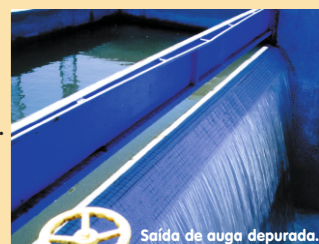
Saída de auga depurada.
