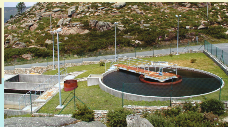
Estación de potabilizadora dunha pequena localidade.
